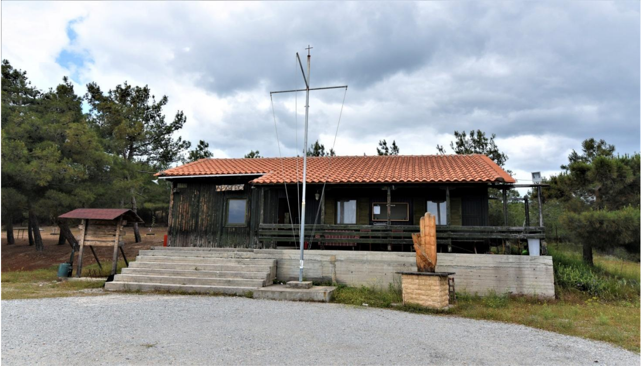
Εικόνα 1: Εξωτερική όψη του ξύλινου καταφυγίου.
